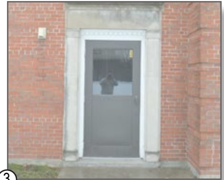
③ HOLLOW METAL DOOR & WOOD FRAME
