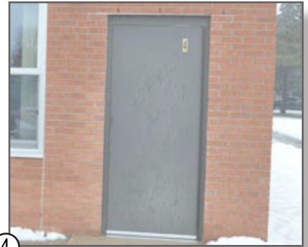
④ HOLLOW METAL DOOR & HOLLOW METAL FRAME
